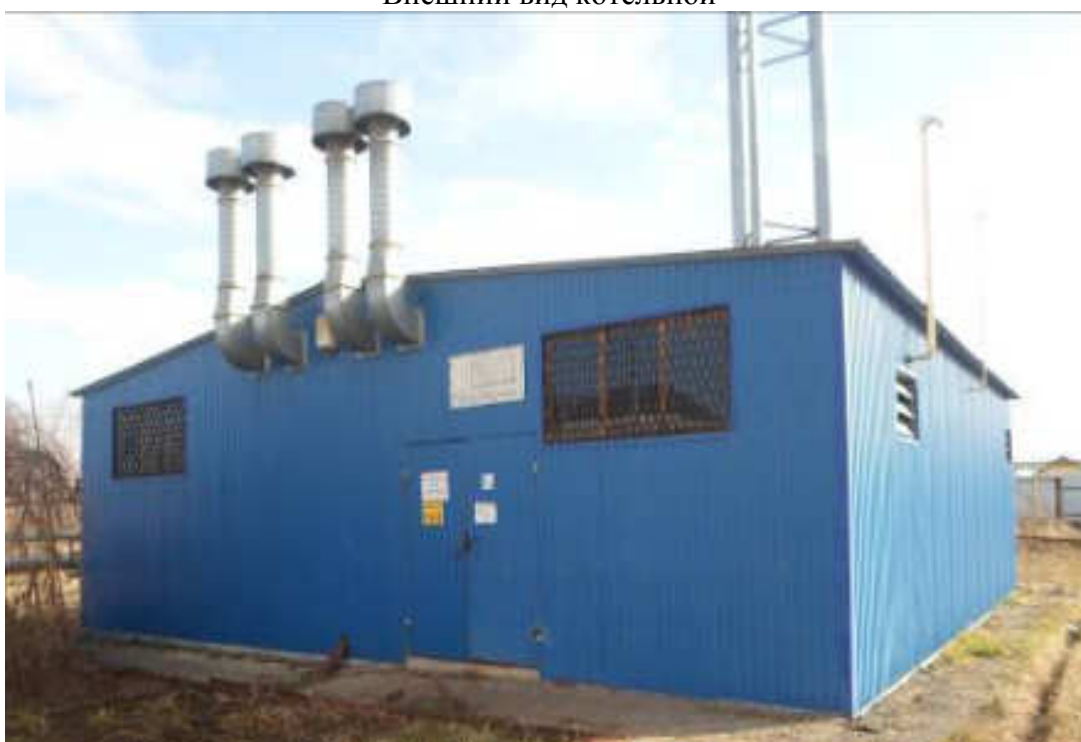
Видимое изображение №1 Внешний вид котельной
