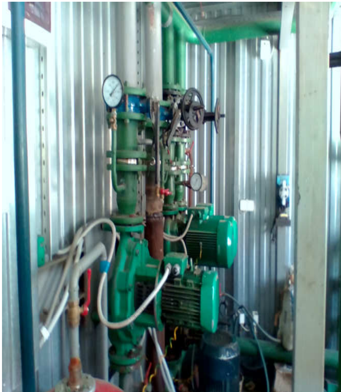
Видимое изображение №2 Обвязка насосов
