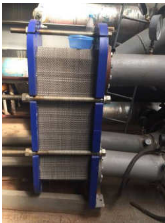
Видимое изображение №3 Теплообменное оборудование
