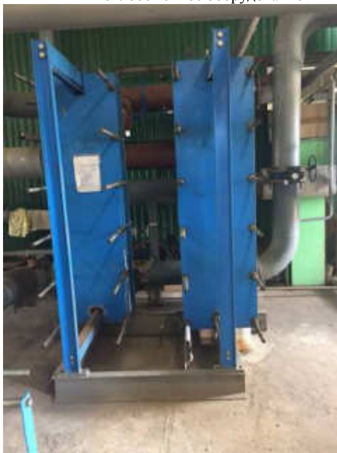
Видимое изображение №3 Теплообменное оборудование
