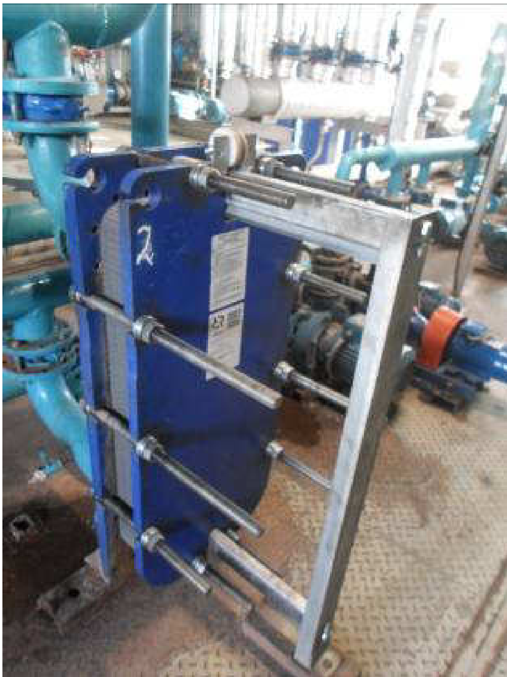
Видимое изображение №3 Теплообменное оборудование
