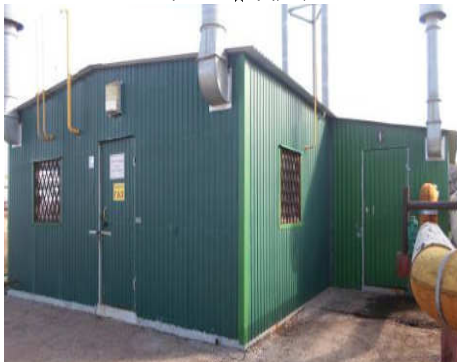
Видимое изображение №1 Внешний вид котельной
