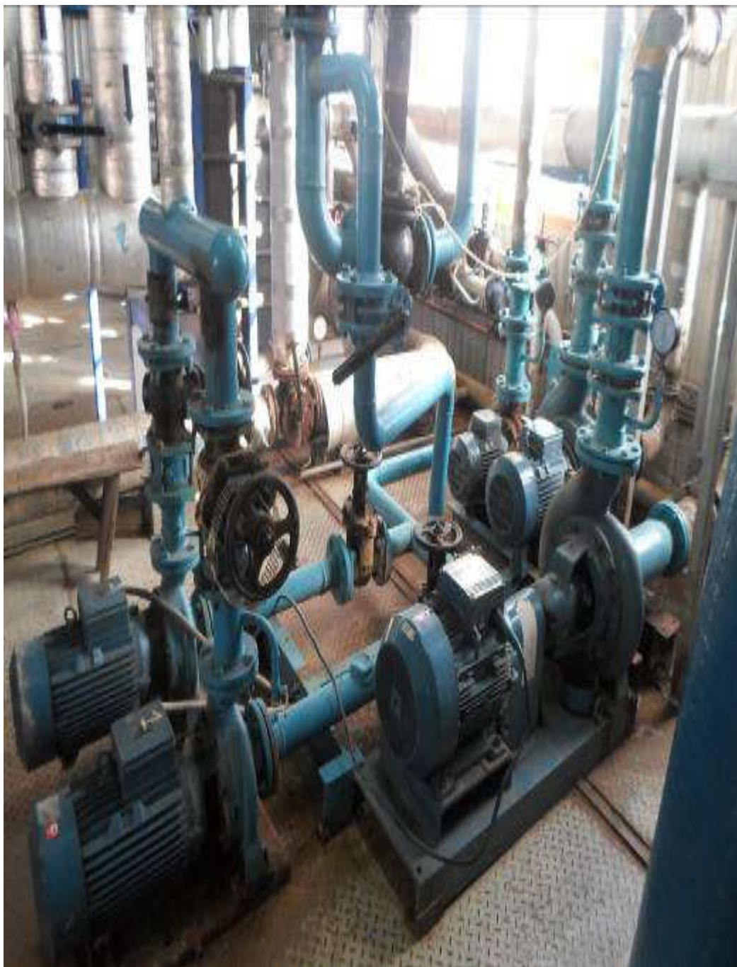
Видимое изображение №2 Обвязка насосов
