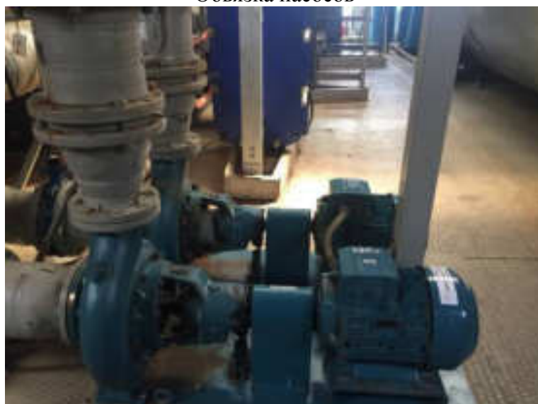
Видимое изображение №2 Обвязка насосов
