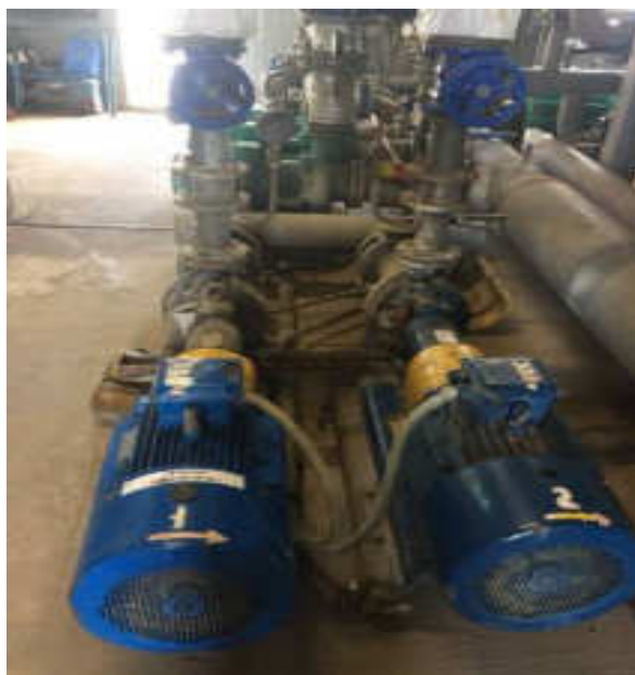
Видимое изображение №2 Обвязка насосов
